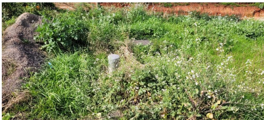
Figura 42: Poço Parque de Rodeios desativado.
