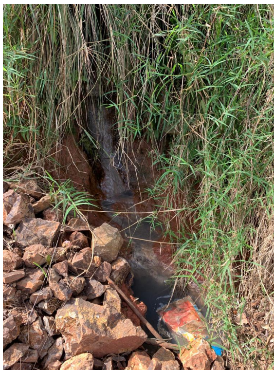
Figura 191: Ponto 1 de deságue de águas pluviais em Mato Castelhano/RS.
