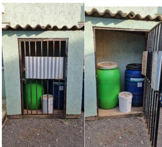
Figura 161: Local de armazenamento dos resíduos sólidos de saúde.
