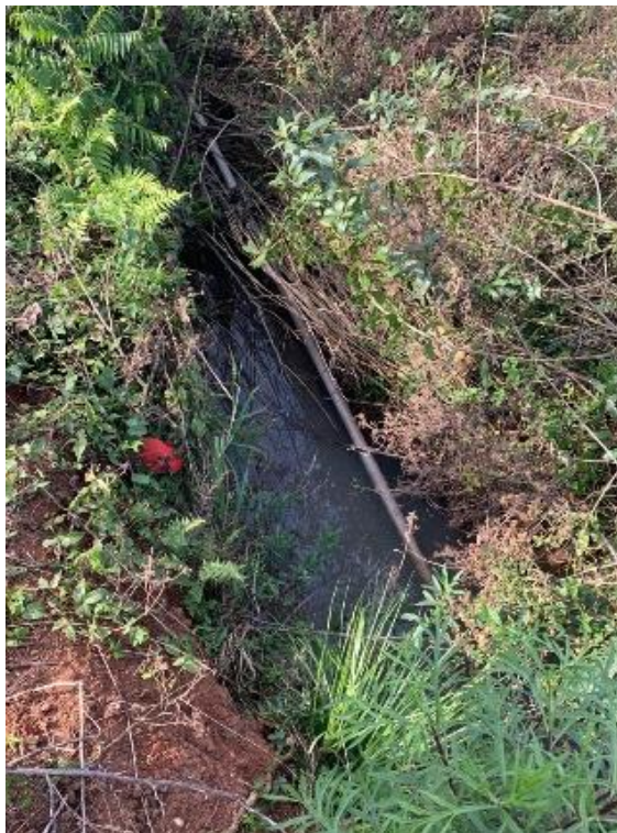
Figura 195: Terceiro ponto de deságue com grande quantidade de esgoto.
