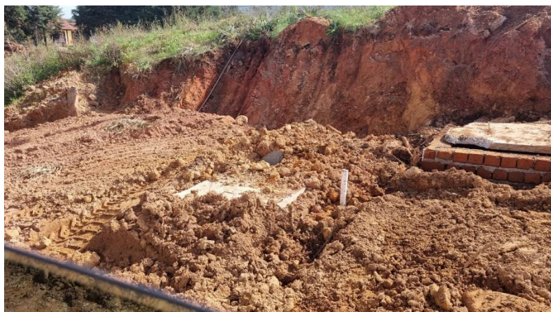
Figura 183: Rede de drenagem sendo implantada.
