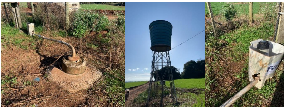
Figura 65: Poço, reservatório e tratamento Nossa Senhora de Lourdes (Propriedade Adilson Siqueira).
