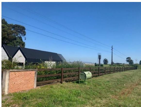
Figura 127: Lixeira inadequada para acondicionamento dos resíduos.
