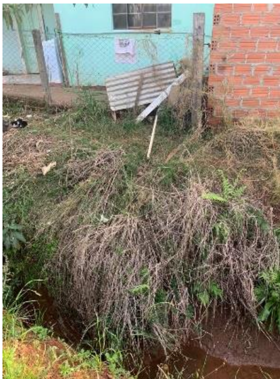
Figura 202: Encanamento de esgoto doméstico sendo direcionado próximo ao ponto de deságue.
