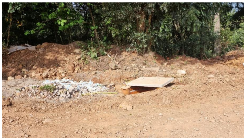
Figura 180: Rede de drenagem sendo implantada.
