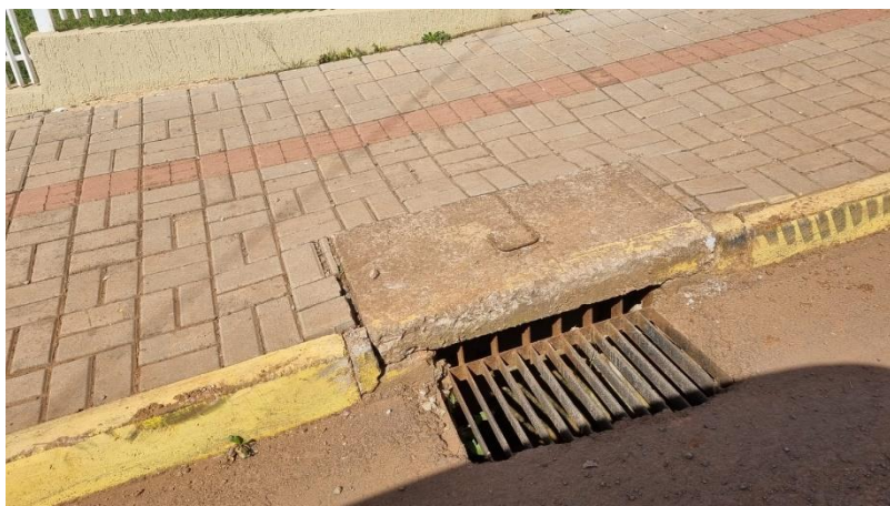
Figura 173: Boca-de-lobo combinada.
