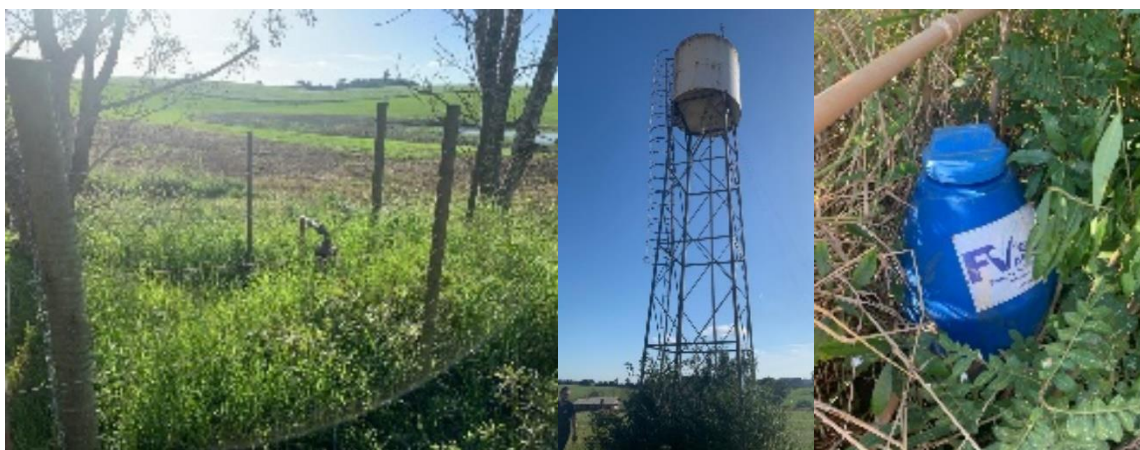
Figura 66: Poço, reservatório tratamento Santo Antônio dos Pobres (Propriedade Edo Novelo).
