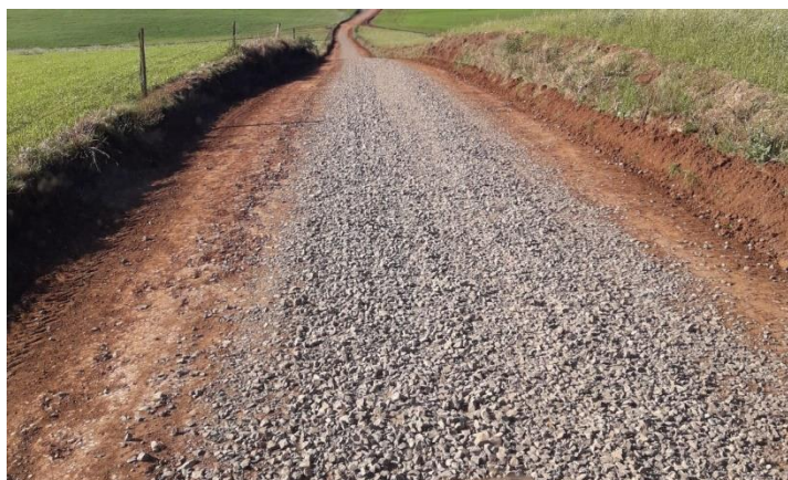
Figura 203: Drenagem pluvial na área rural.
