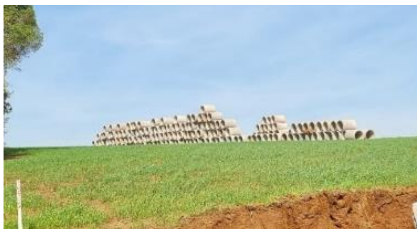
Figura 182: Tubulações para a nova rede de drenagem.
