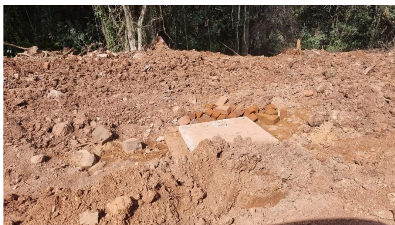
Figura 181: Boca-de-lobo sendo implantada.
