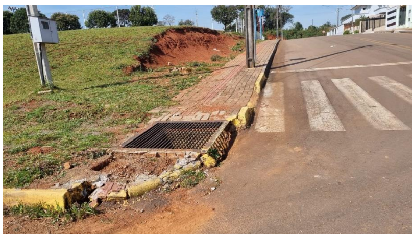
Figura 172: Rua com drenagem pluvial.
