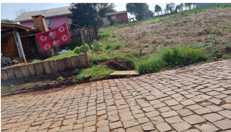
Figura 187: Boca-de-lobo danificada.
