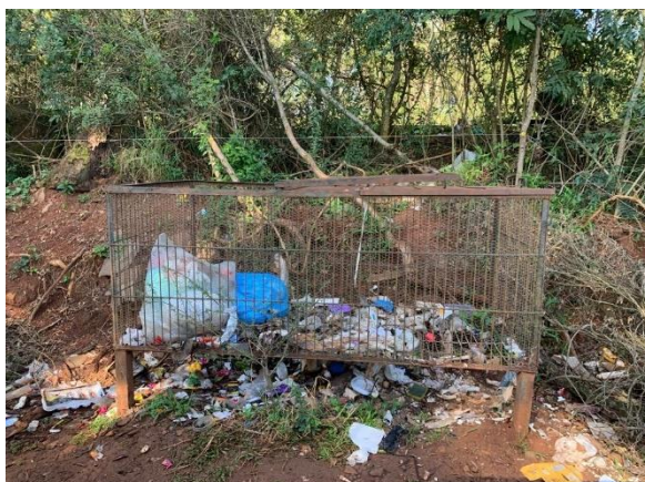
Figura 126: Lixeira sem suporte de elevação com resíduos espalhados no chão.
