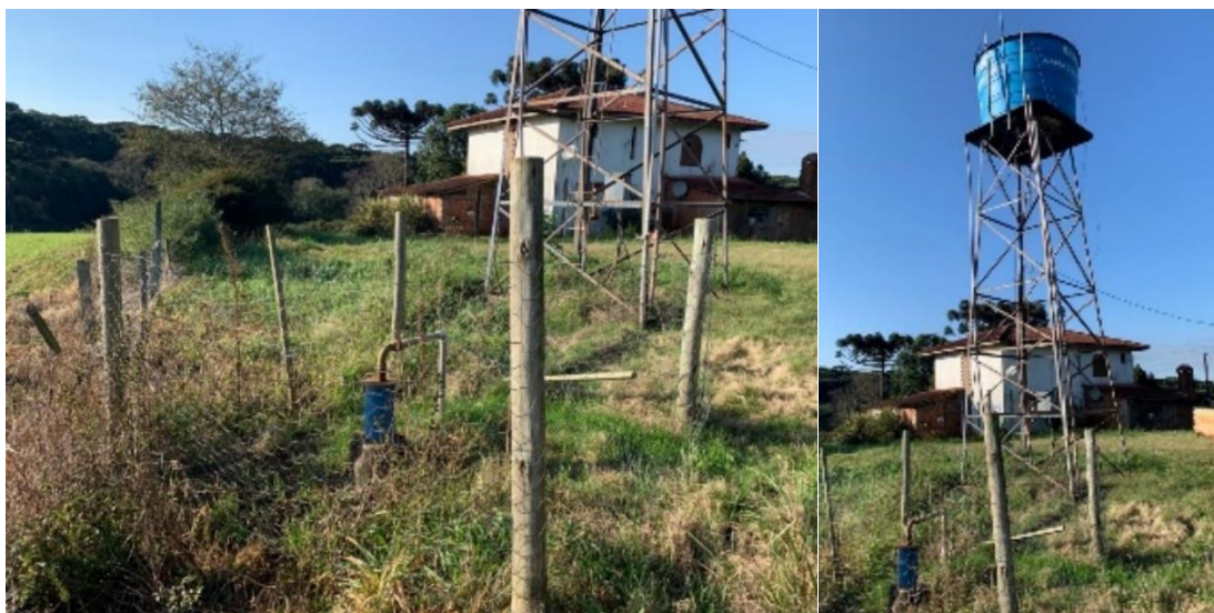
Figura 45: Poço e reservatório Santo Antônio dos Gregolos (Propriedade Paulo Lunelli).
