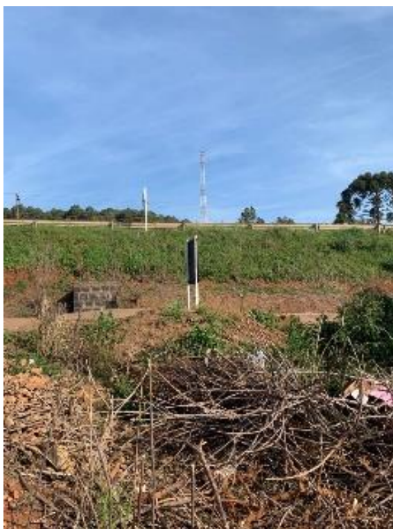
Figura 201: Quarto ponto de deságue das águas pluviais.
