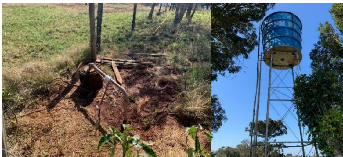
Figura 50: Poço e reservatório Capinguí (Propriedade de Almerindo do Prado).
