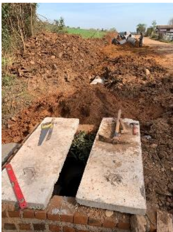
Figura 194: Ponto de deságue das águas pluviais junto ao rio.
