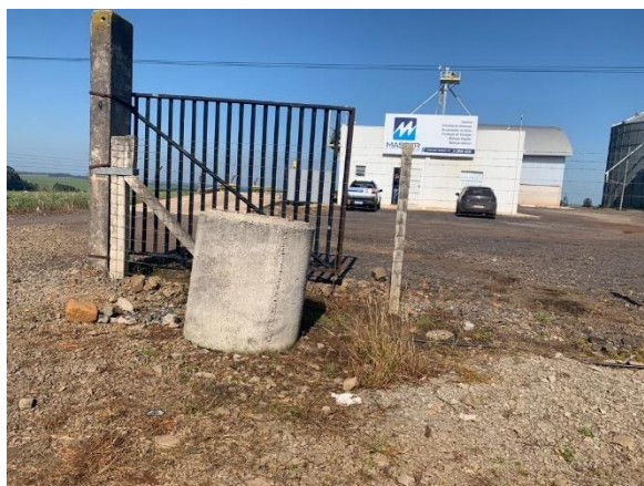
Figura 128: Lixeira inadequada para acondicionamento dos resíduos.
