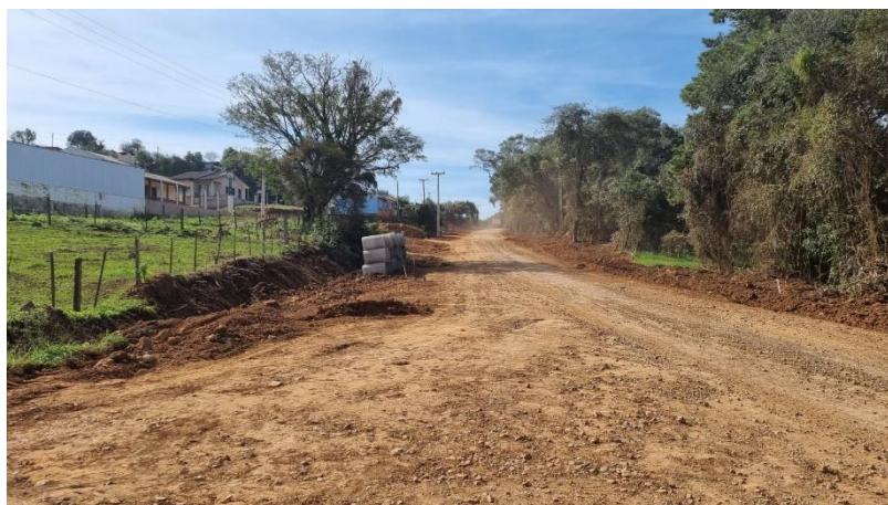
Figura 184: Rede de drenagem sendo implantada.
