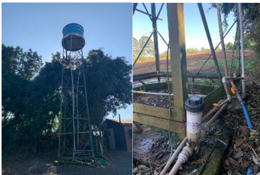
Figura 49: Reservatório e tratamento no Capinguí Consoladora.
