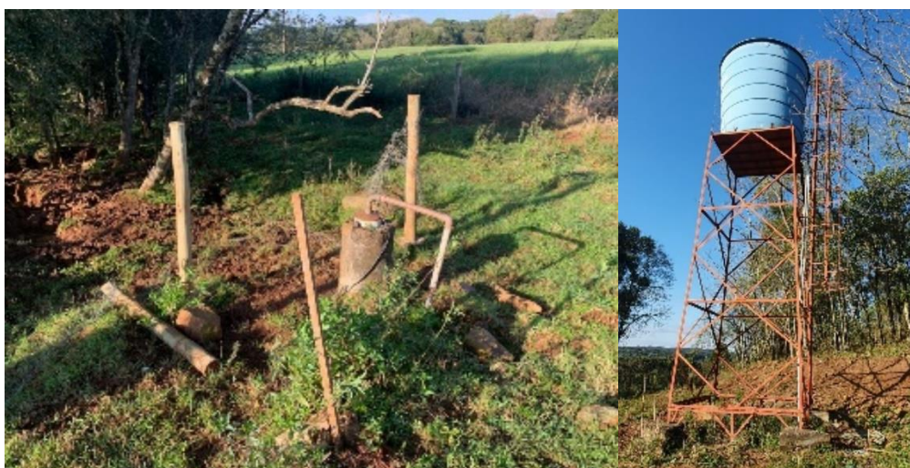
Figura 44: Poço e reservatório Santo Antônio dos Gregolos (propriedade Neli França).
