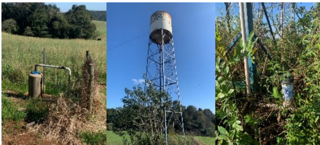
Figura 55: Poço, reservatório e tratamento Tijuco Preto (Propriedade Jairo Savi).
