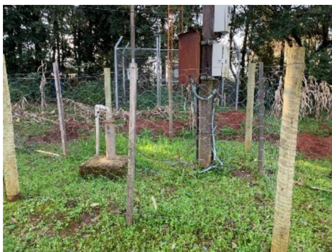
Figura 60: Poço antigo Campina dos Novelos (Propriedade Jelsir Grando).
