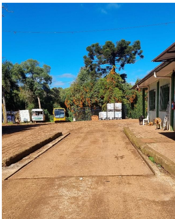
Figura 139: Balança de pesagem dos caminhões.
