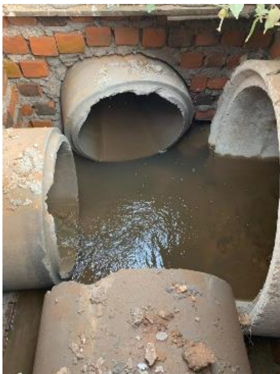
Figura 193: Ponto de deságue das águas pluviais junto ao rio.
