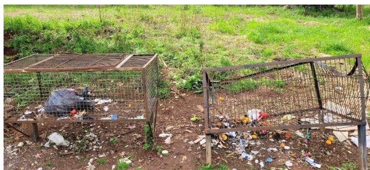
Figura 134: Lixeira danificada com resíduos espalhados pelo chão.
