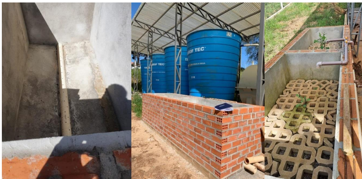
Figura 94: Leito de secagem da ETE de Mato Castelhana.
