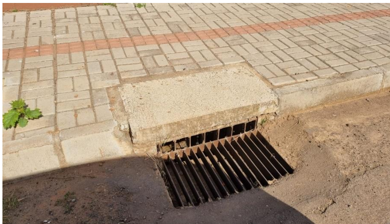
Figura 171: Boca-de-lobo combinada.
